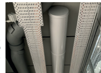
Starre luchtverdeelkanalen Interland Techniek in depot Boijmans van Beuningen
