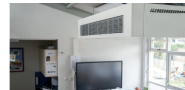
Decentrale schoolventilatie-unit voorzien van WTW
