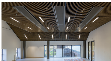
130 plafondunductie-units met VAV-functie.
